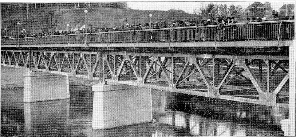
RANGERS BRIDGE, WOODSVILLE, N. H.
